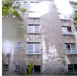
建築部材モニタリング に基づく初期値不要な 劣化検知(計測風景)
