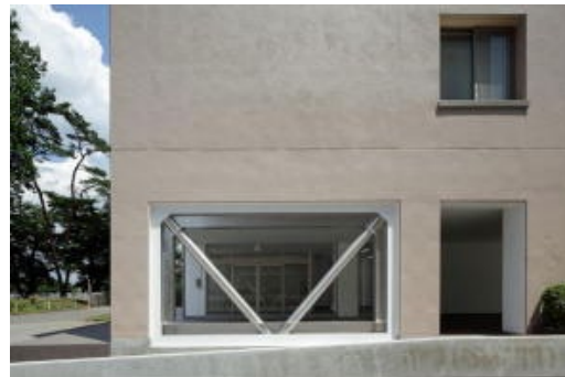
図3 ステンレスブレースによる耐震補強 (宇都宮大学陽東キャンパス8号館)
