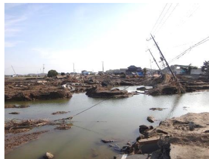
平成27年9月関東・東北豪雨の鬼怒川決壊地点の様子
