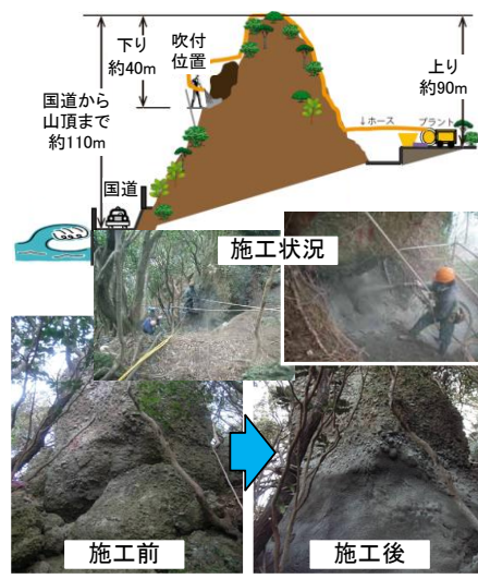
写真 開発した法面保護材の施工例 材料を工夫することで90mの山登りを含め700mの材料移送が可能。従来施工不可能な危険部を保護可能とし安全に寄与します
